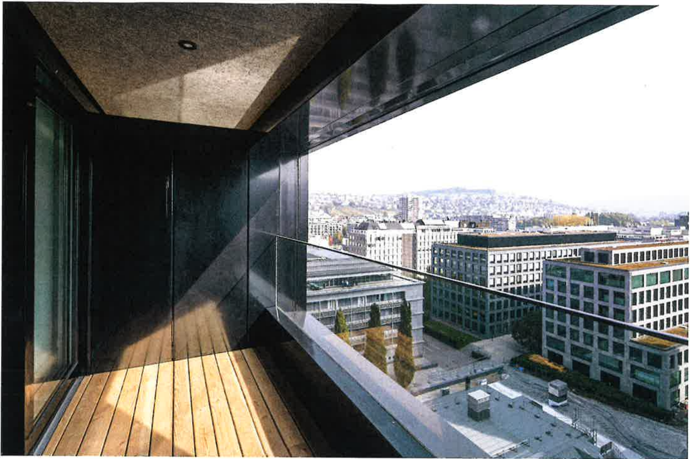
Ausblick vom 24. Obergeschoss des westlichsten Turms der Überbauung. Alle Loggien sind aus Lärmschutzgründen von der Bahnseite abgewandt.
